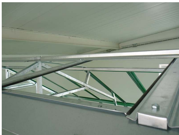
Detail zasklení hřebenové části.
