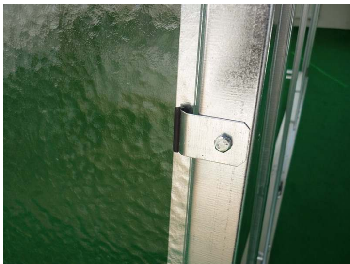
Přichycení bočního skla přičtykou poz. 83-1
