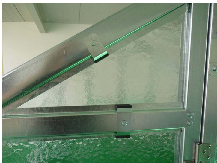
Přichycení skla k pozici 72 přičtykou 83-1 a 83-2
