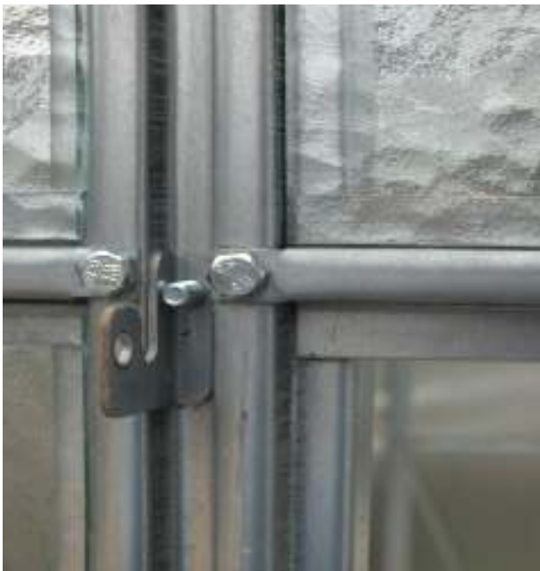
Detail umístění závěsů na sloupek čela (poz. 7).
